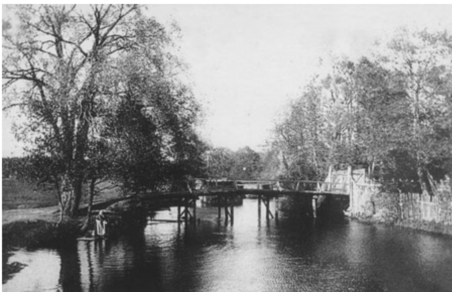
Малаховка. Мост у мельницы (близ обрыва).
