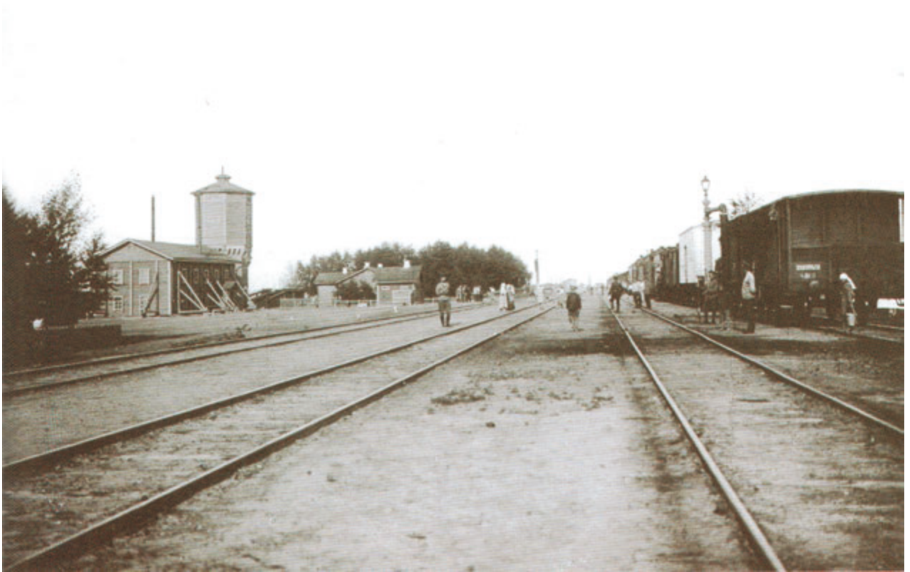
Станция Марьяновка. Лето 1918 г.
